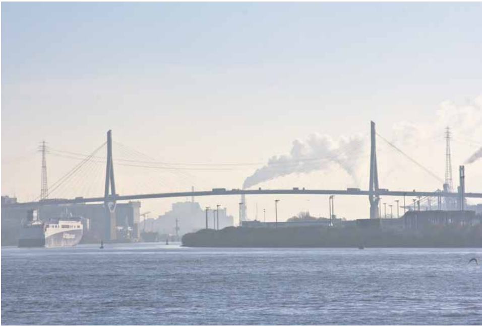
Zeitlos, aber nicht ewig: Das Denkmal Köhlbrandbrücke wird nach 2030 verschwinden
